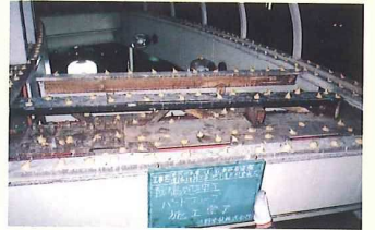
▲バードフリーブ施工
